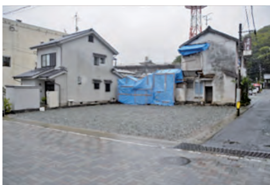
建物が取り壊され空き地となった箇所 (古町地区)
