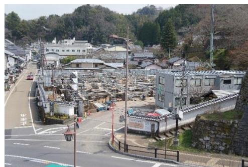
建設中の歴史文化交流センター
