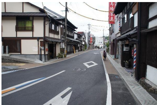
道路美装化が完了した本町通
