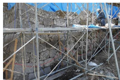
岡城跡石垣復旧の様子
