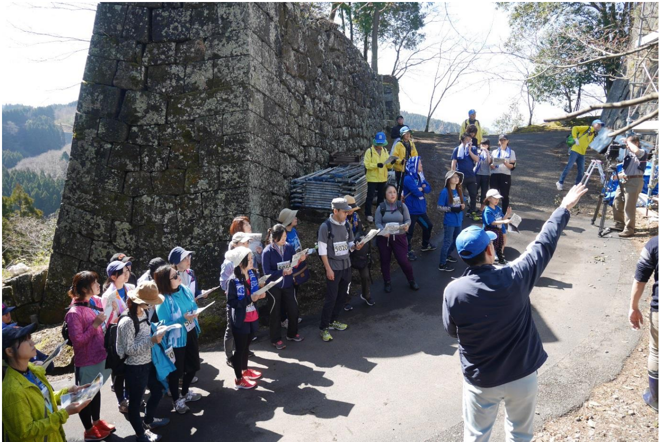
岡城跡下原門跡石垣修復現場説明会の様子
