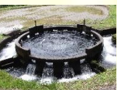
音無井路12号分水
