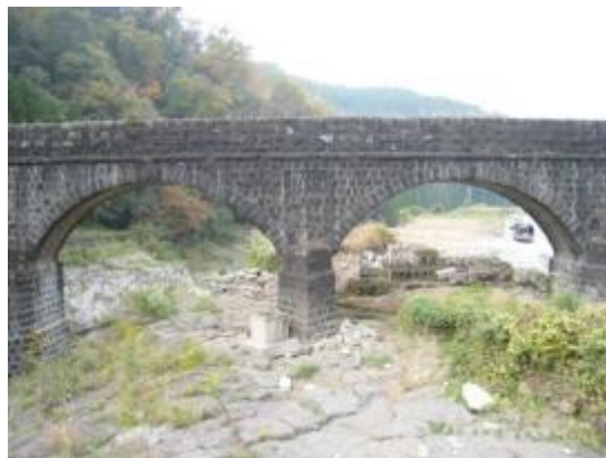
明正井路第一拱石橋
