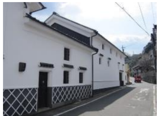
吉川家住宅倉庫一
