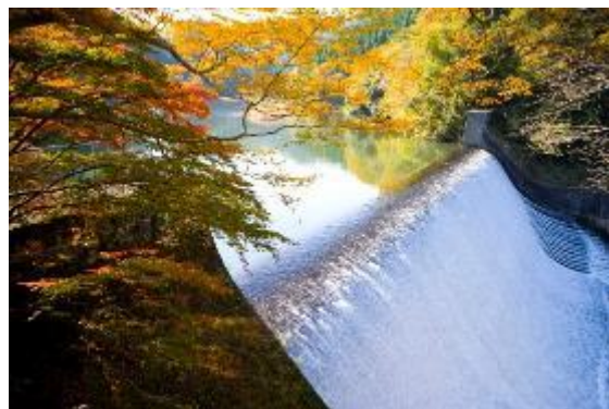
白水溜池堰堤水利施設
