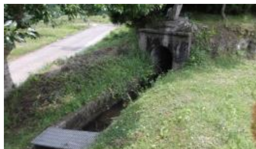
音無井路 2 号暗渠入口
