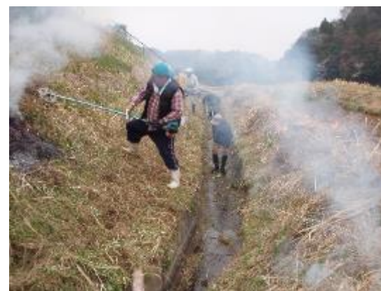
幹線の除草作業の様子②
