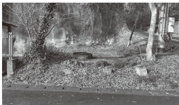
有蓋の防火水槽
