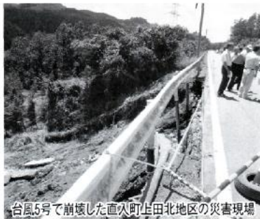
台風5号で崩壊した直方町土北地区の災害現場
