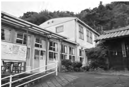
大正14年に建設された現在の市立図書館
