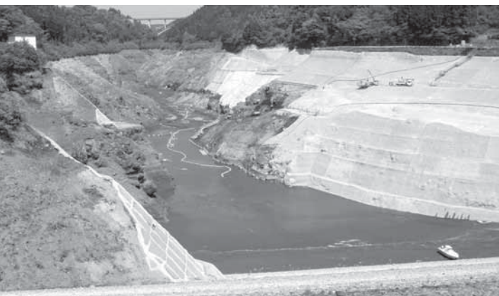
浸透抑制対策工事中の大蘇ダム
