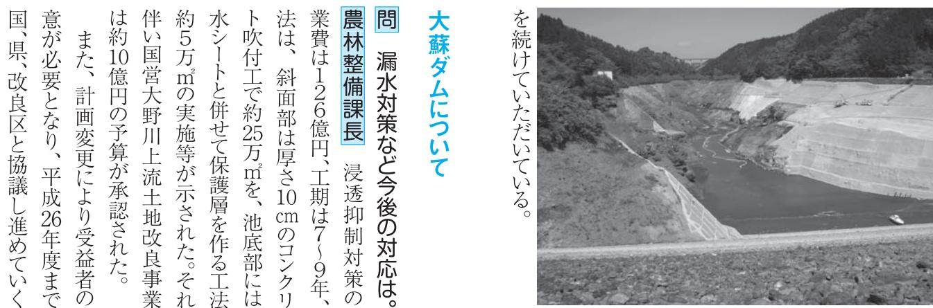
▲浸透抑制対策工事中の大蘇ダム
