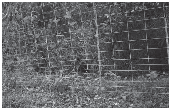
▲猪に曲げられた防護柵
