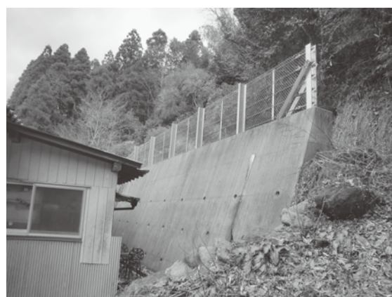
▲急傾斜対策工事後の例
