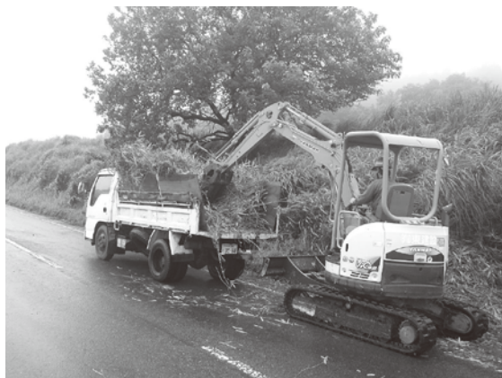
▲業者委託による除草作業の様子
