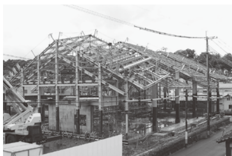
▲建設中の新図書館
