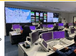
【消防通信指令センター】
