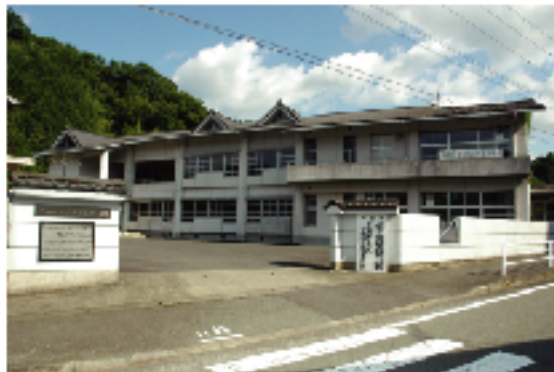
竹田市福祉施設「はくすい」(旧宮砥小学校)
