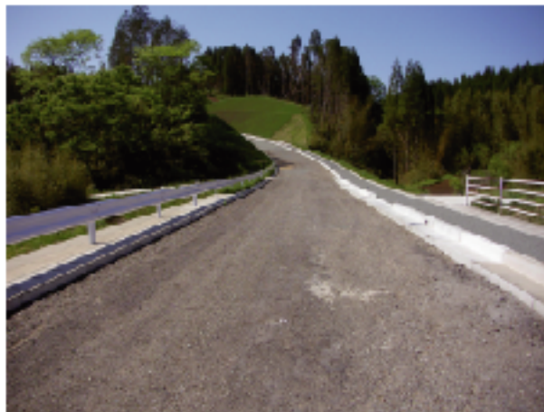
市道宮原米賀線改良事業
