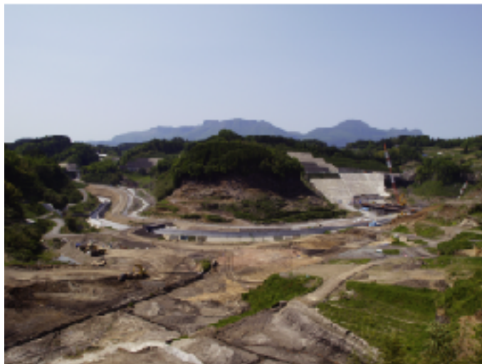
建設中の稲葉ダム
