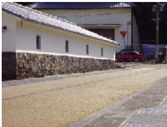
カラー舗装された市街地の道路
